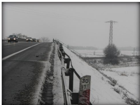
Most nad linią kolejową w m. Lubice
